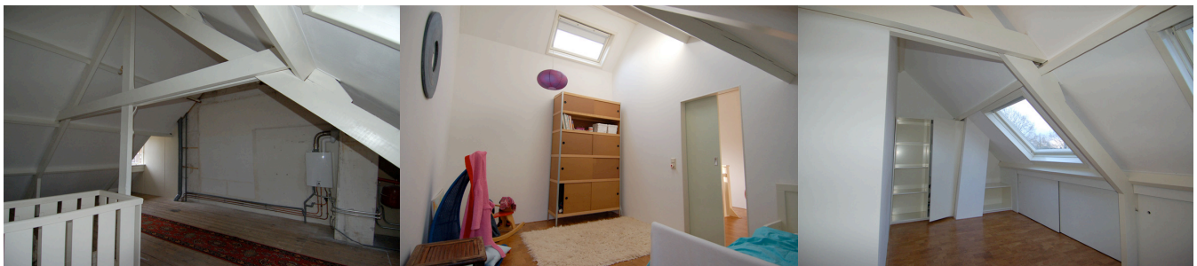
Zolderruimte voor verbouwing
